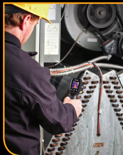
Проверка системы отопления
